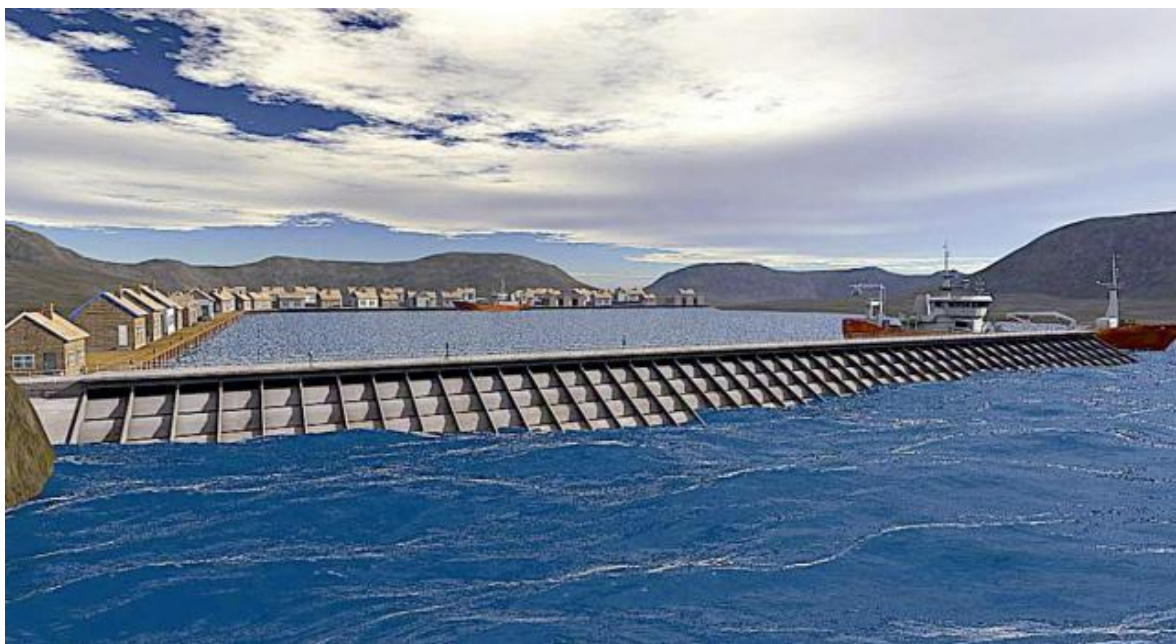
Figur 24. WaveEnergy (Sandnes) sitt anlegg, her som del av molo. (Prinsipp nr 1 i figur 21).
