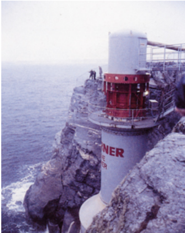
Figur 23. Kværner Brug sin OWC (prinsipp nr 2 i figur 21) og Norwave sin bølgerenne ved Toftestallen, Sotra (prinsipp nr 1 i figur 21).
